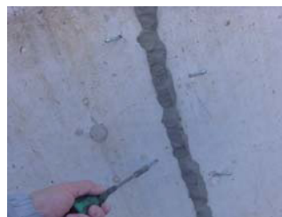
③注入プラグ設置： 逆止弁付き注入プラグを設置します
