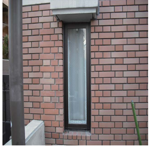
タイル復旧、施工完了
