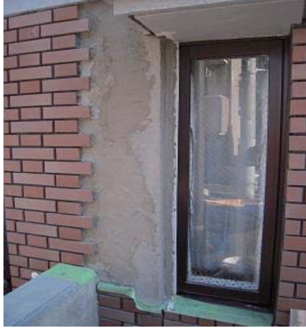
NB エラスティックで防水
