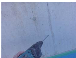
①穿孔： クラックに対し 45 度の角度に 穿孔します
